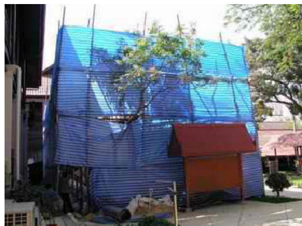
รูปที่ 1-1 ตัวอย่างรั้วกันเขตก่อสร้าง
